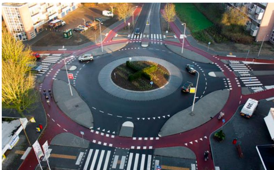
Figura 3.21 Esempio di rotonda con circolazione anello ciclabile tangente a Rotterdam nei Paesi Bassi
