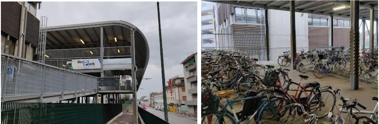
Figura 3.48 "Bici Park", la velostazione in dotazione alla stazione ferroviaria di Mestre (VE)
