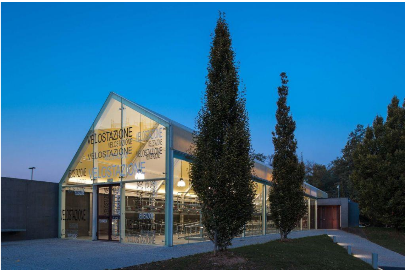
Figura 3.49 Velostazione in dotazione alla stazione ferroviaria di Cesano Maderno (MB)
