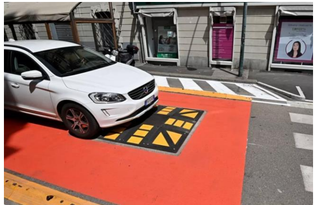
Figura 3.31 Esempi di cuscino berlinese: il dispositivo di moderazione permette il passaggio in piano dei veicoli a due ruote.
