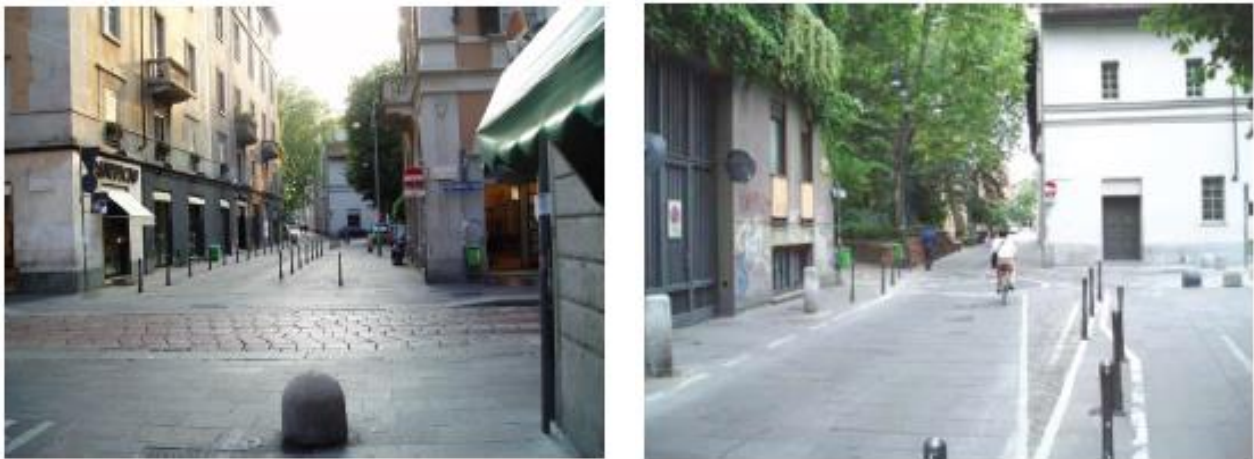
Figura 3.14 Nei contesti fortemente moderati, la separazione della circolazione ciclabile contromano deriva da giudizi più estetici che funzionali. Nella foto sopra e in quella a fianco sono riportati due tratti della medesima strada nei quali si adottano due diverse soluzioni. Nell'immagine di destra la corsia ciclabile contromano non ha qui nessuna protezione ed è regolata dall'usuale segnale di divieto di accesso con pannello integrativo 'escluso biciclette' [Milano - Foto Polinomia]
