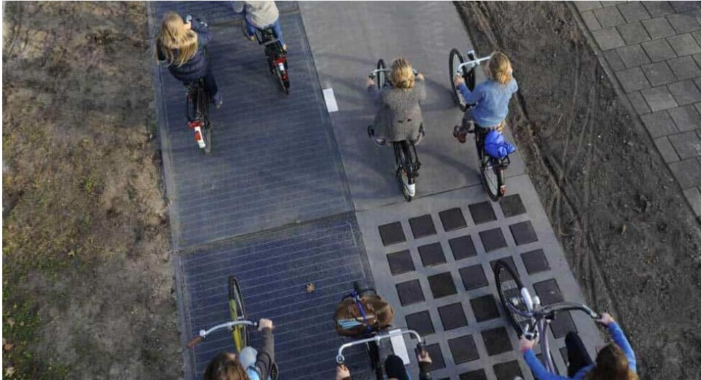
Figura 3.36 Esempio di pista solare fotovoltaica
