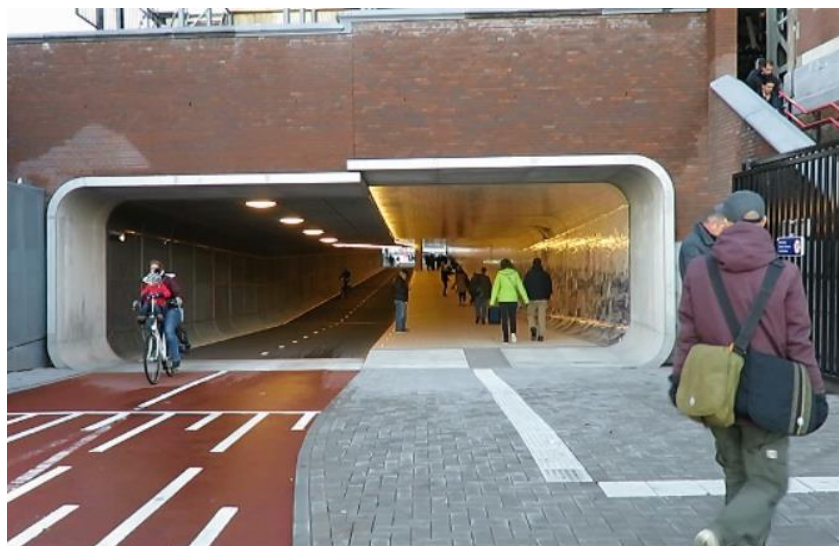
Figura 3.37 Galleria ciclopedonale sotto i binari della stazione ferroviaria di Amsterdam, Paesi Bassi
