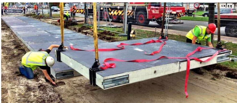
Figura 3.35 Posa delle lastre contenenti le griglie fotovoltaiche
