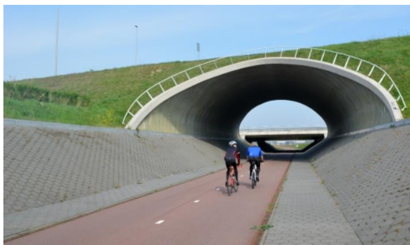
Figura 3.40 Sottopasso ciclabile senza variazione di quota sotto l'autostrada a Gouda, Paesi Bassi
