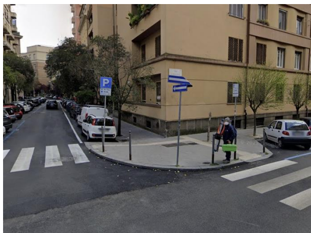
Allargamento del marciapiede – Via Reggio Calabria (Roma)
