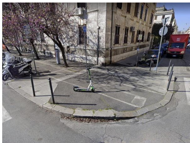
Allargamento del marciapiede in asfalto – Via Nicola Zabaglia (Roma)
