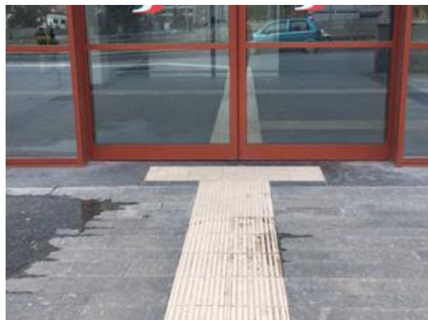
Segnali tattili di ingresso ad un edificio, Stazione ferroviaria di Imperia
