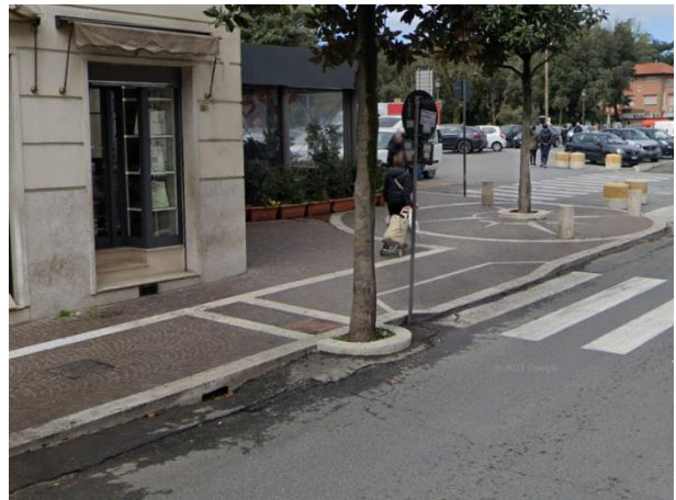
Realizzazione nuovo marciapiede in porfido – Corso G. Matteotti (Albano Laziale)
