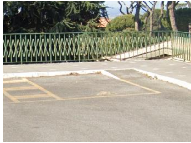
Rampe disabili in corrispondenza posto auto disabili, aggiunta – Viale S. G. Battista de la Salle (Castel Gandolfo)
