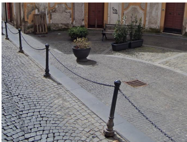
Protezione di percorso pedonale a raso (Parigina) – Via Alcide De Gasperi (Albano Laziale)
