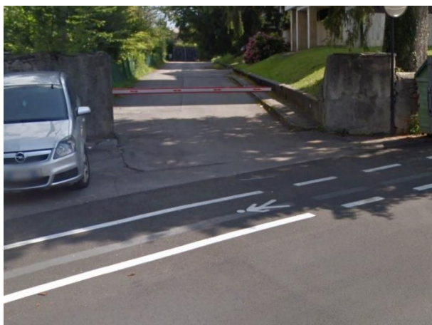
Percorso pedonale in asfalto – Via Trevozzoi (Belluno)
