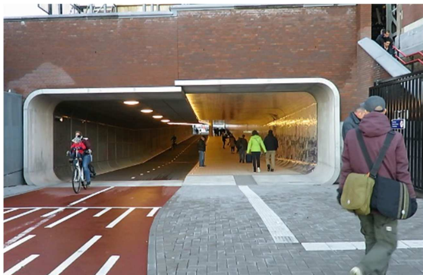
Figura 3.37 Galleria ciclopedonale sotto i binari della stazione ferroviaria di Amsterdam, Paesi Bassi
