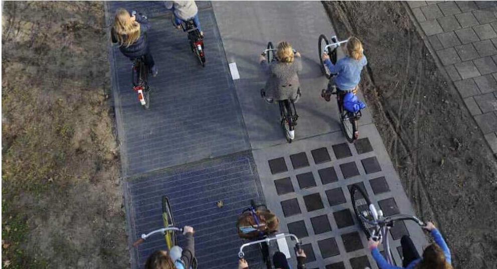
Figura 3.36 Esempio di pista solare fotovoltaica
