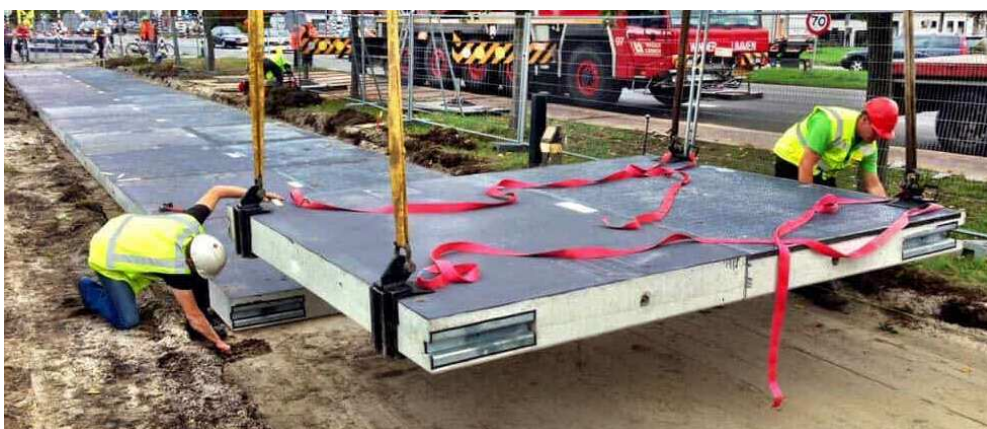
Figura 3.35 Posa delle lastre contenenti le griglie fotovoltaiche
