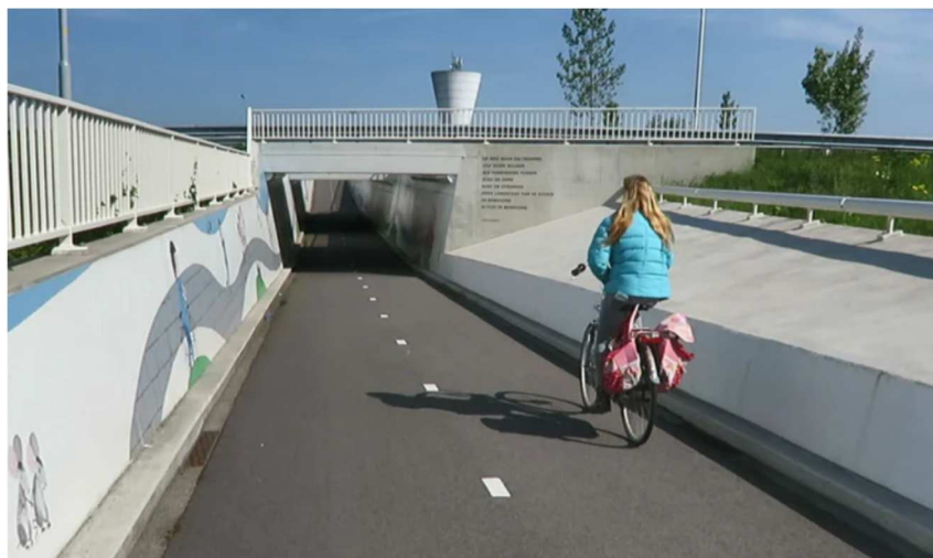
Figura 3.39 Sottopasso ciclabile con variazione di quota sotto un'infrastruttura primaria nella città di Zaltbommel nei Paesi Bassi
