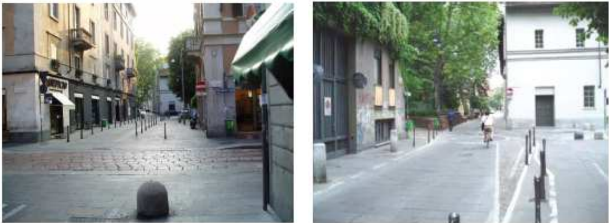
Figura 3.14 Nei contesti fortemente moderati, la separazione della circolazione ciclabile contromano deriva da giudizi più estetici che funzionali. Nella foto sopra e in quella a fianco sono riportati due tratti della medesima strada nei quali si adottano due diverse soluzioni. Nell'immagine di destra la corsia ciclabile contromano non ha qui nessuna protezione ed è regolata dall'usuale segnale di divieto di accesso con pannello integrativo 'escluso biciclette' [Milano - Foto Polinomia]
