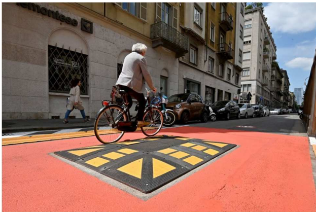
Figura 3.31 Esempi di cuscino berlinese: il dispositivo di moderazione permette il passaggio in piano dei veicoli a due ruote.
