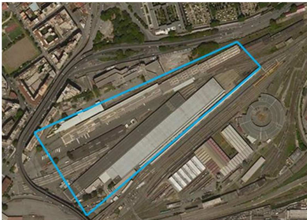
Figura 5.21 Vista dello scalo di Roma san Lorenzo
