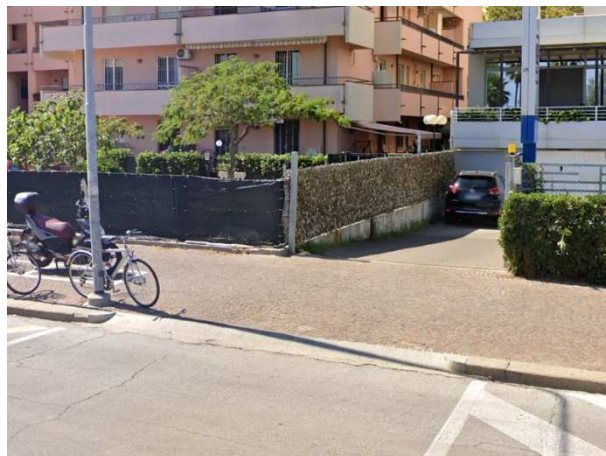
Allineamento passi carrabili alla stessa quota del marciapiede, in porfido - Lungomare G. Di Vittorio (Rimini)
