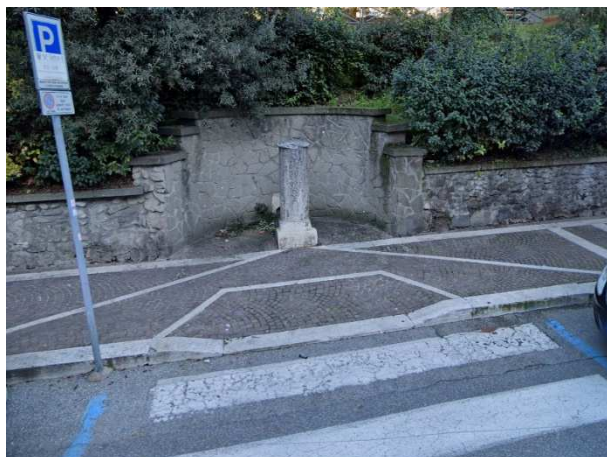
Rampe di raccordo tra marciapiede e sede stradale, in porfido - Borgo Garibaldi (Albano Laziale)
