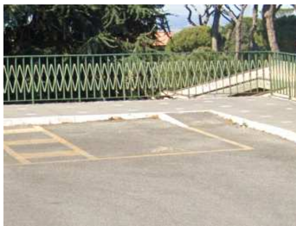
Rampe disabili in corrispondenza posto auto disabili, aggiunta – Viale S. G. Battista de la Salle (Castel Gandolfo)
