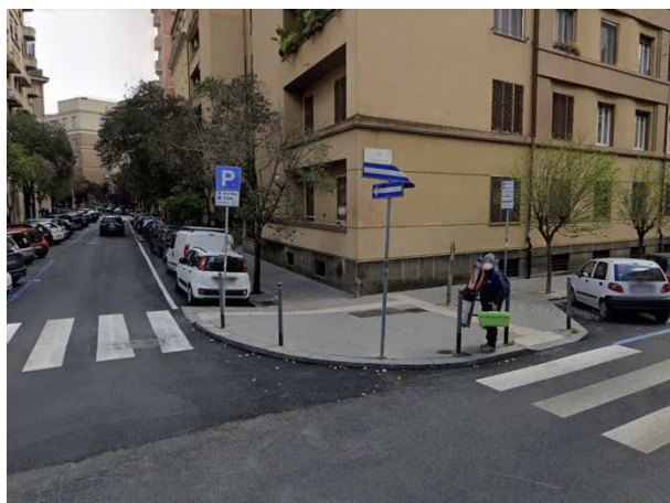
Allargamento del marciapiede – Via Reggio Calabria (Roma)
