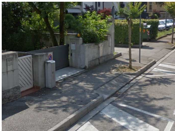
Allineamento passi carrabili alla stessa quota del marciapiede, in asfalto - Via Carli Galeotto (Sacile)
