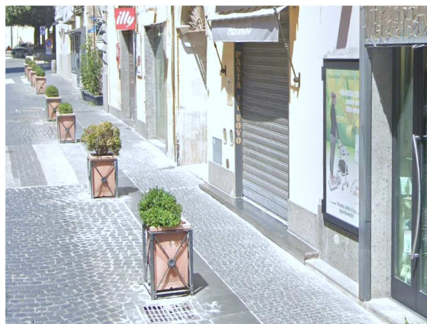
Protezione di percorso pedonale a raso (Fioriera) – Via Alcide De Gasperi (Albano Laziale)
