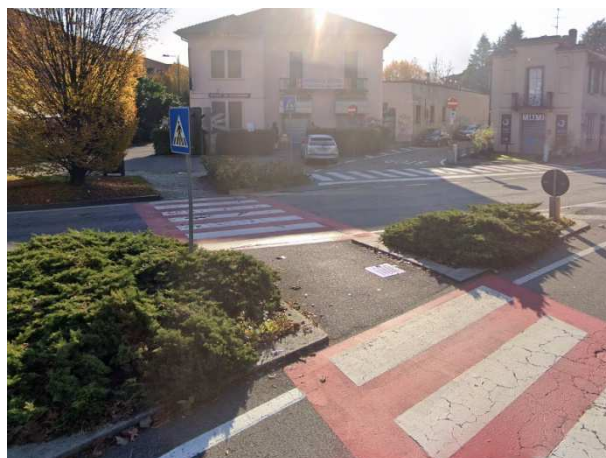
Differenziazione cromatica di attraversamento pedonale Via Milano (Vimercate)
